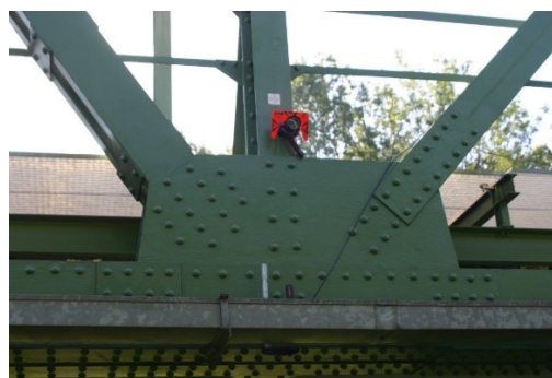
Slika 2: Penatgonalna prizma i samoljepljiva geodetska prizma za praćenje pomaka
